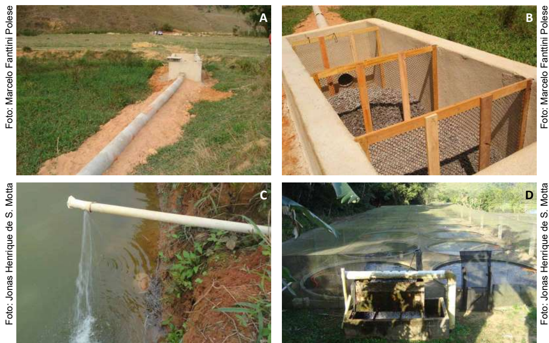
Figura 27. Sistema de abastecimento de água: tubulação de distribuição em concreto (A); caixa de distribuição com telas para retenção de macroimpurezas (B); tubo perfurado na entrada do viveiro para regulagem da entrada de água e aumento da oxigenação da água de abastecimento (C); filtro de brita para retenção de macroimpurezas e predadores e aumento da oxigenação da água de abastecimento (D).
