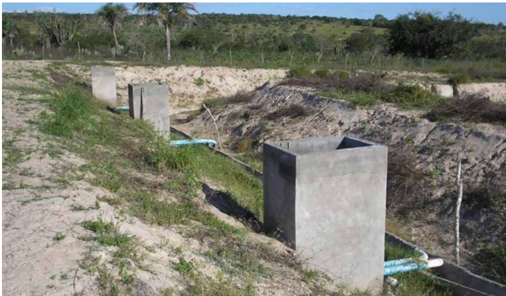
Figura 36. Monge instalado na parte externa do viveiro escavado.
