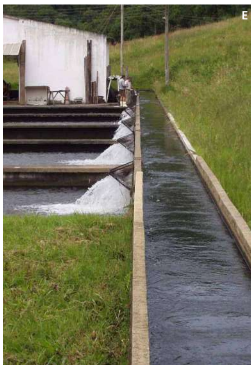
Figura 26. Sistema de abastecimento de água. Viveiros revestidos com lona e tubulação de distribuição enterrada: entrada de água individual e 0,30 m acima da água (A1); grama em volta dos viveiros para proteção na área de cultivo (A2); borda livre de 0,30 m (A3); talude que separa os viveiros e permite acesso (A4); canaletas de alvenaria e tubulação de derivação de água para os tanques de alvenaria (B, C, D e E); filtro de tela no controle de predadores (C1); entrada de água individual e com altura suficiente para aeração (C2).
