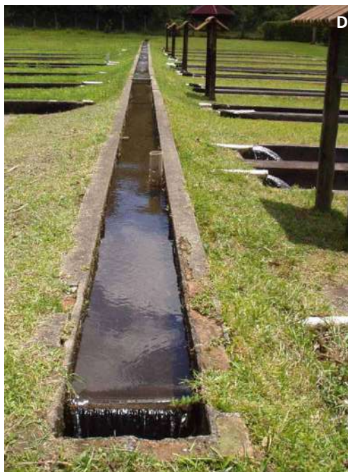
Figura 26. Sistema de abastecimento de água. Viveiros revestidos com lona e tubulação de distribuição enterrada: entrada de água individual e 0,30 m acima da água (A1); grama em volta dos viveiros para proteção na área de cultivo (A2); borda livre de 0,30 m (A3); talude que separa os viveiros e permite acesso (A4); canaletas de alvenaria e tubulação de derivação de água para os tanques de alvenaria (B, C, D e E); filtro de tela no controle de predadores (C1); entrada de água individual e com altura suficiente para aeração (C2).
