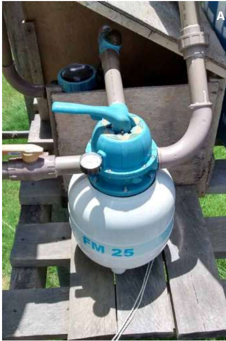
Figura 60. Filtro de areia (para piscina): instalações hidráulicas (A e B); filtro de 520 L com bomba de 3,0 cv, 32 m 3 /h em sistema de 50 m 3 (B).
