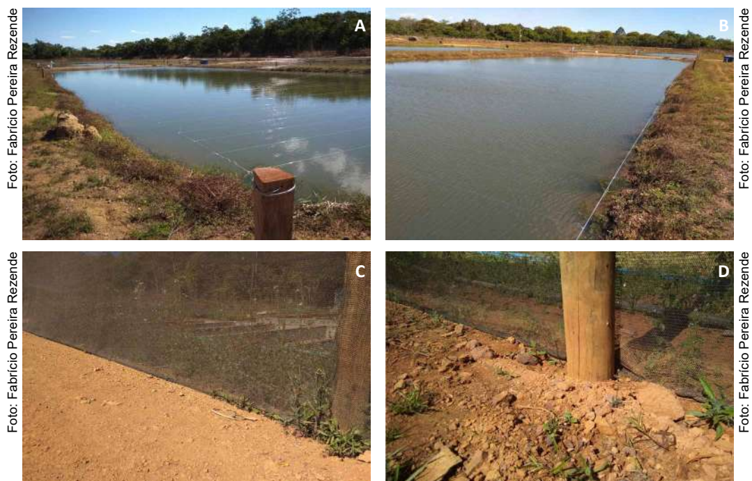
Figura 66. Proteção com telas antipássaros: linhas de náilon dispostas sobre um viveiro com espaço de 40 cm entre elas (A e B); acabamento na costura da tela anti-insetos em arame próximo ao solo (C e D).
