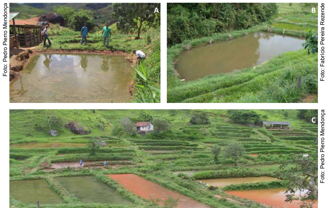
Figura 3. Vista panorâmica de viveiros escavados de pequeno volume, usados na produção semi-intensiva de peixes ornamentais de baixo valor agregado: distrito de Santo Antônio do Glória, Vieiras, MG (A e C) e Eugenópolis, MG (B).
