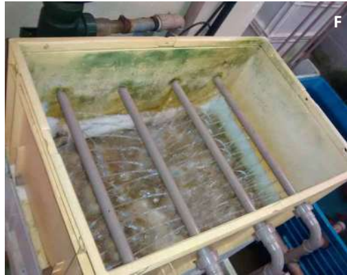
Figura 61. Filtro biológico: com mídias fluidizáveis compostas por recortes de conduítes com 30 mm (A); com mídias de nanoesferas em camadas semi-inundadas ou dry-wet (B); filtro rizosférico (C); detalhe da drenagem do filtro rizosférico para o tanque de abastecimento (D); filtro dry-wet (E); detalhe de compartimento com lâ filtrante no filtro dry-wet (F).
