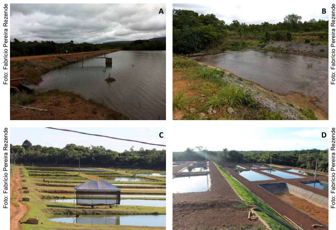
Figura 18. Barragem construída para o abastecimento de piscicultura por gravidade por meio de monge (A), vertedouro da barragem protegido por enrocamento (B), viveiros abastecidos em condutos fechados com caixas de passagem e inspeção (C) para o melhor aproveitamento do terreno e viveiros impermeabilizados em geomembrana construídos em diferentes platôs abastecidos por condutos fechados (D).
