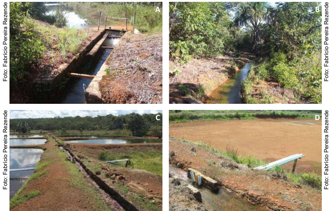
Figura 25. Sistema de abastecimento de água em viveiros: ponto de captação de água por gravidade de barragem (A); canaleta em solo (B); canaleta com pontos de derivação de água para os viveiros (C e D).
