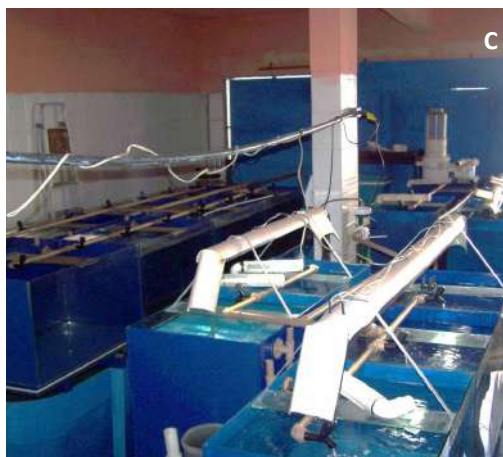
Figura 14. Produção de cavalo-marinho em estrutura in door em um empreendimento no estado do Espírito Santo: vista externa das salas de produção (A); aquários de manutenção de matrizes em sistema de recirculação de água na parte superior e caixas-filtro na parte inferior (B); vista superior das bancadas de aquários com iluminação, sistema de abastecimento e drenagem (C); vista de filtro escumador (D).
