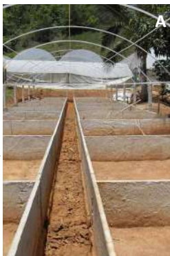
Figura 50. Tanques de placas de concreto: fase de montagem dos tanques com as placas de concreto (A); detalhe de instalação de dreno pelo fundo antes de forração com a lona (B); vista panorâmica da uma estufa e tanques em fase de montagem (C).
