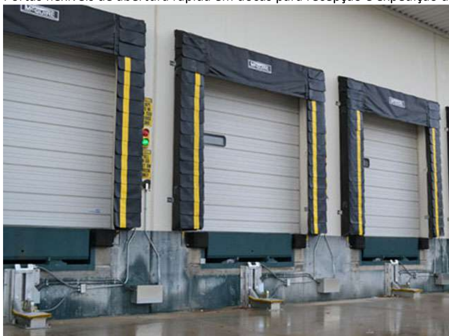
Figura 101 – Portas flexíveis de abertura rápida em docas para recepção e expedição de câmara fria.
