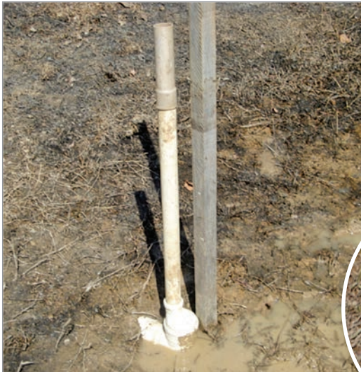
D) Tubo de esgotamento montado
