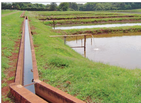
Figura 15. Sistema de Abastecimento
