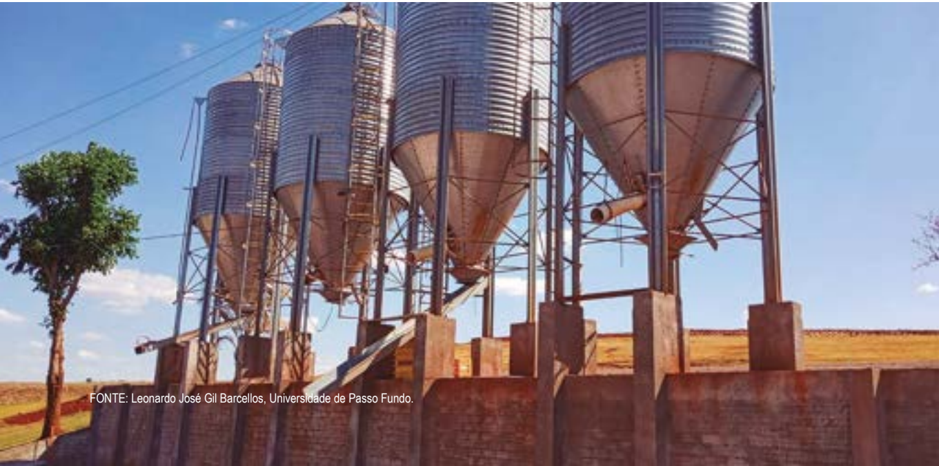
FIGURA 6.3 – Silos de recepção e armazenagem de ração à granel
