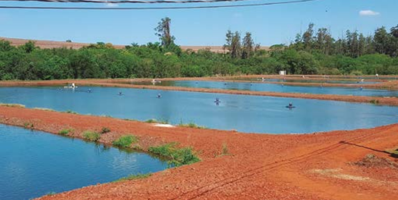
FIGURA 5.1 - Tanques escavados, corretamente construídos
