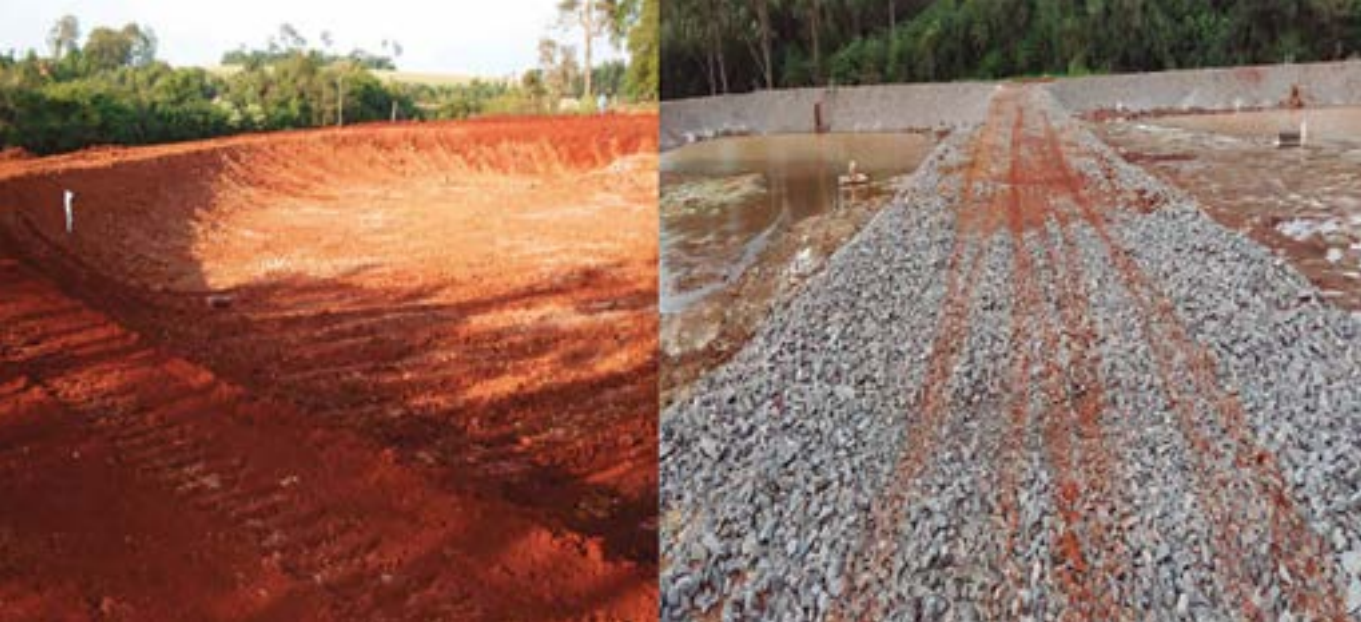
FIGURA 5.9 - Processo de construção de tanques escavados no Município de Maripá, PR. Esquerda: escavação concluída; direita: empedramento da crista e dos taludes
