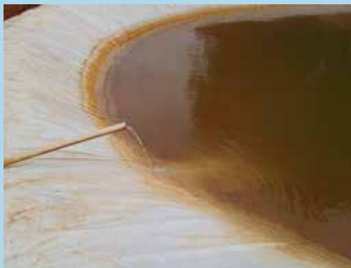
Entrada de água por gravidade em tanque escavado lonado
