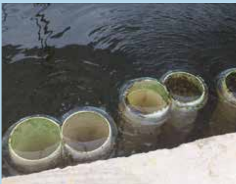
Entrada de água por bombeamento em tanque escavado
