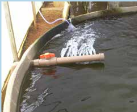
Entrada de água do tanque de ferrocimento
