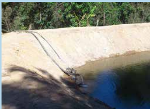
Entrada de água em tanque de decantação (tanques de ferrocimento)
