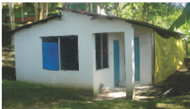
Galinheiro em solo e cimento - EMARC Valença
