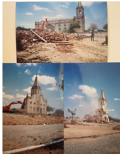
Figura 3 - Demolição da igreja
